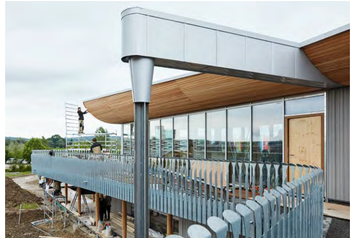
Wegen der ausdrucksstarken Bauteile war schon früh der Charakter des Hauses erkennbar
