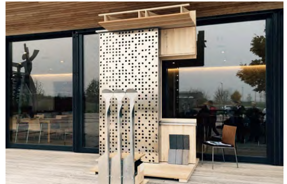
Fassadenfragmente im Maßstab 1:1 vor der Hausschneiderei
