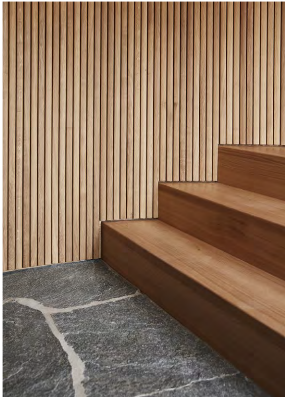
Der Kavala-Granit zieht sich vom Außenraum bis in das EG des Stöcklis hinein
