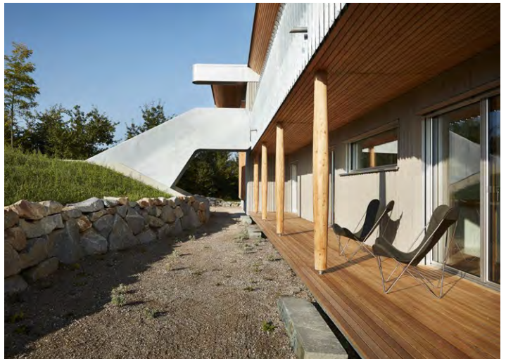
Auf der Südseite übernimmt der Steg die Funktion einer Veranda
