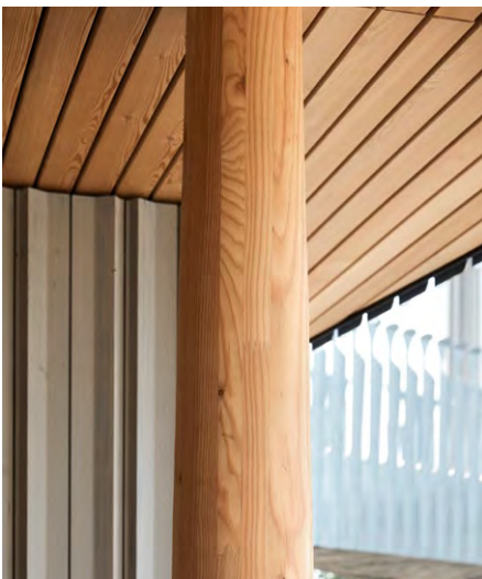
Zigarrenförmige Stütze bei der Arkade zum Eingang
