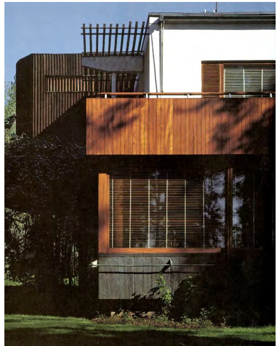
Die südwestliche Ecke der Villa Mairea von Alvar Aalto mit einer Vielzahl von Materialien
